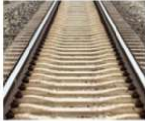
在铁轨下面铺枕木
